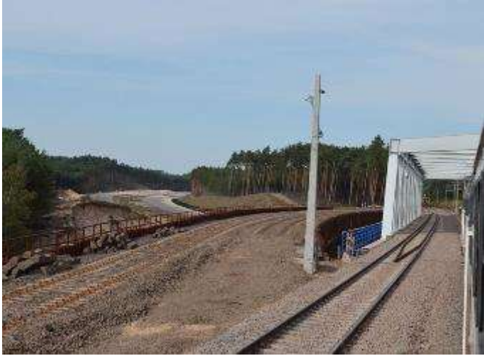
2. Tory objazdowe na czas budowy wiaduktu (Budowa A1 pod Otłoczynem)
