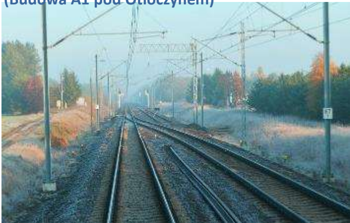
3. Tymczasowy rozjazd (CMK), żeby skrócić odcinek jednotorowy
