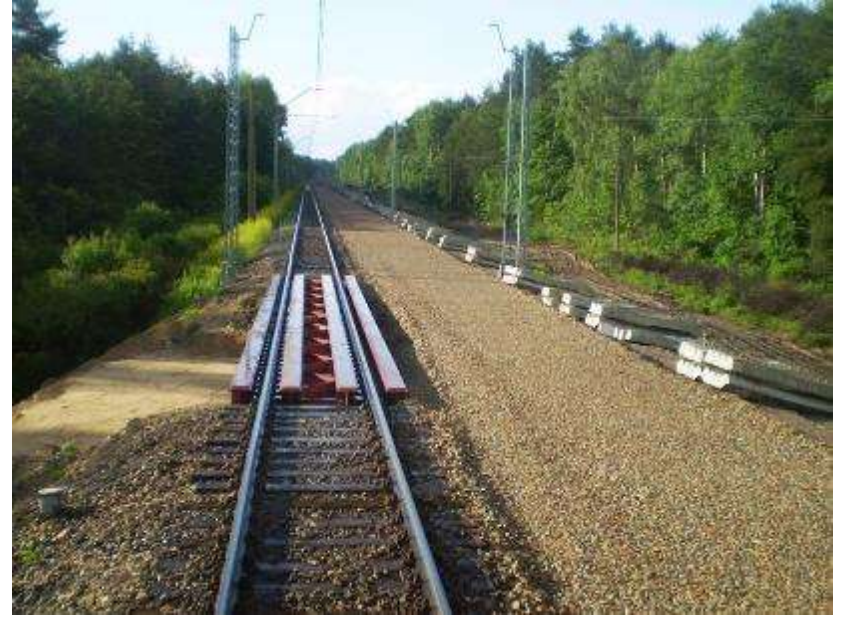
4. Przerwa w ruchu tylko na położenie dźwigara (Modlin – Nasielsk) na tymczasowych palach. Docelowe przyczółki i filary buduje się później, pod ruchem. Tak jak stacje metra: najpierw najwyższy strop, potem wybiera się pod nim ziemię, niższy strop, na końcu filary.
